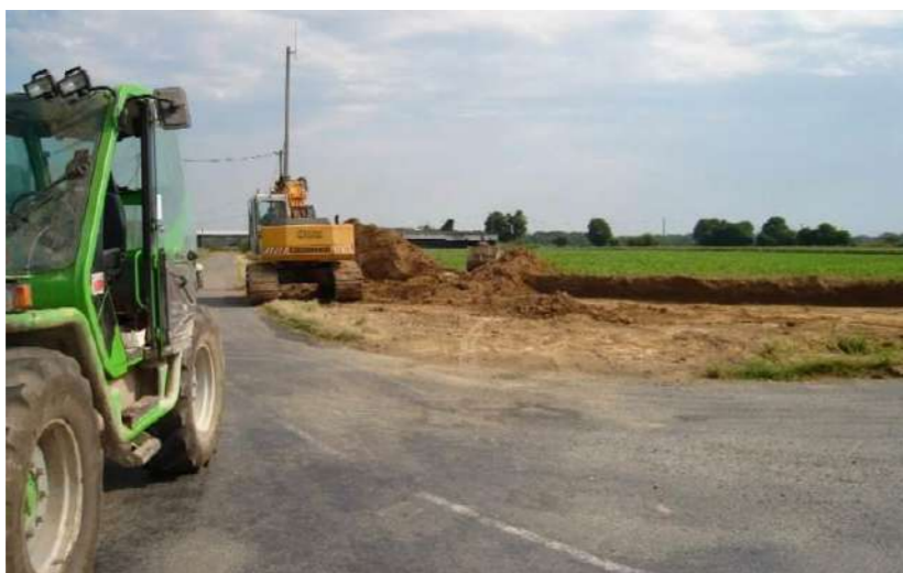
Photo 341 : Les travaux de rectification d'un virage
